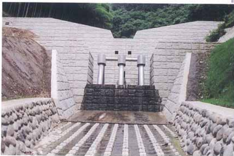
兵庫県浜坂土木事務所 発注 訓谷川通常砂防工事 割石60【特注柄厚t60mm】1・2・4タイプ 指定色浸透着色
