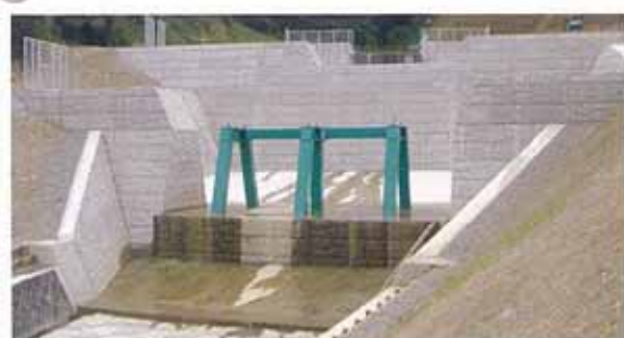
滋賀県大津土木事務所 発注 ホッケ谷通常砂防工事
