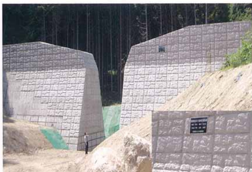
京都府南丹土木事務所 発注 奥条谷川通常砂防工事 背面 (上流側)・埋設面 あいパネル [黒塗装] 使用
