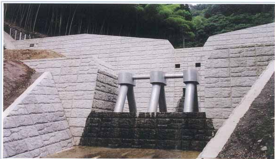
砂防堰堤施工例 【兵庫県豊岡土木事務所・但東事業所発注、久畑宮ノ奥川砂防工事】
