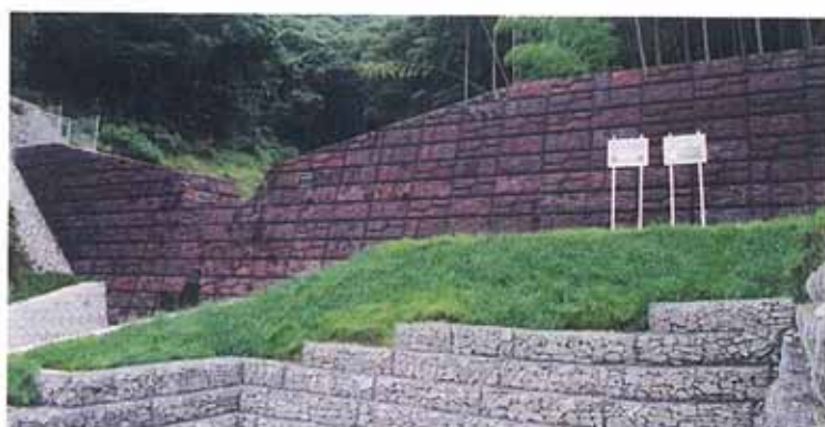
兵庫県浜坂土木事務所 発注 訓谷川通常砂防工事 割石60【特注柄厚t60mm】1・2・4タイプ 指定色浸透着色
