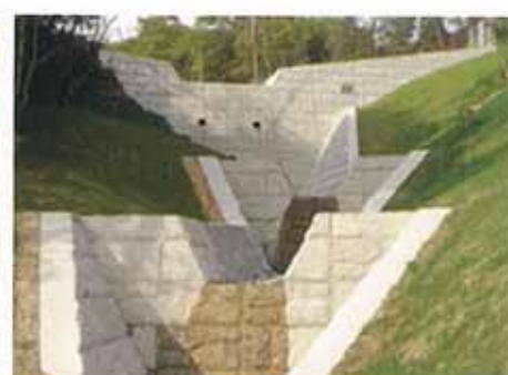
大岩谷補助通常砂防(1号2号ダム)工事
