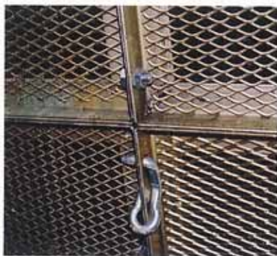
パネル連結はUクリップとボルトナットの選択です
