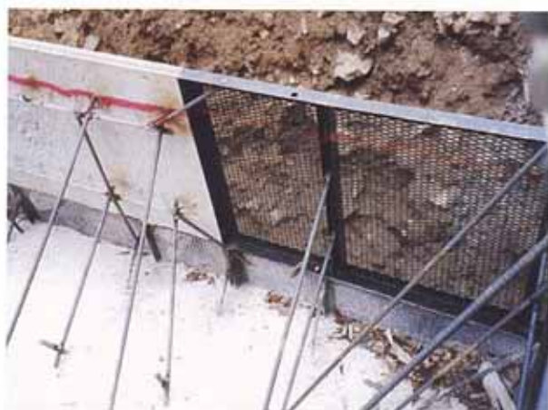
「ゆうパネル」と連結設置箇所
