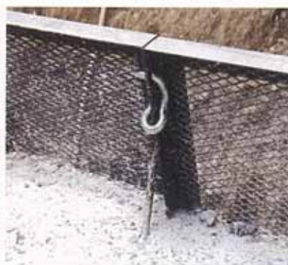
パネル連結はUクリップとボルトナットの選択です
