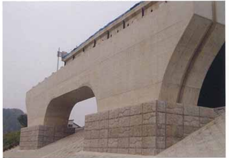
残存型枠「鞘管工法」
