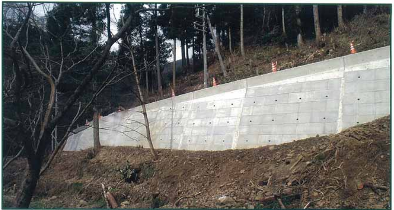
兵庫県村岡町発注 和佐父線道路改良工事
