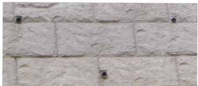
端部を切断し水抜き位置を決め、仕上げはモルタル処理
