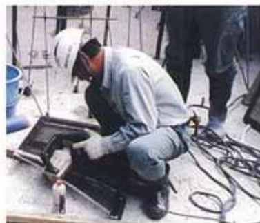
「高速サンダー」にて簡単に切断
