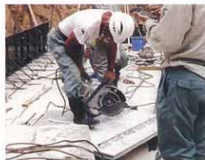
鉄筋とコンクリートゆえ、ダイヤモンドカッターを使用します
