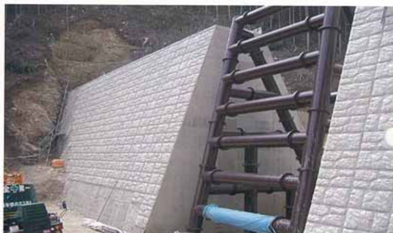
奈良県吉野土木事務所 発注 ヒウラ谷川通常砂防工事(1期) 割石40(1・2・4)タイプ
