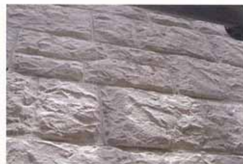
千鳥状 (ヌノ積) 積み上げ ↑ ↓ 上流側 (背面) 化粧仕上げ
