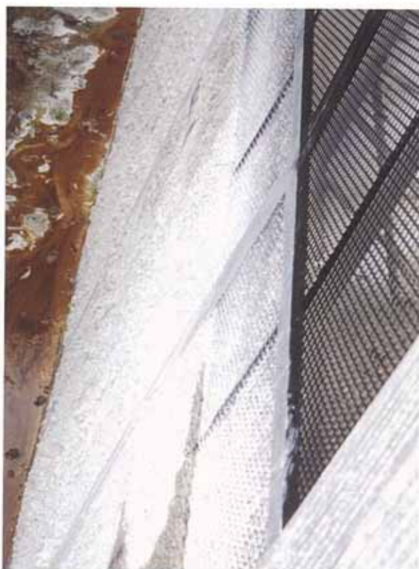
打設後の仕上がり状況（ハツリ状）
