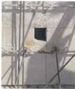
1パネルに上下2本（計4本）支持鉄筋を直接熔接固定
