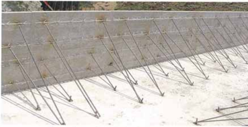
1パネルに上下2本（計4本）支持鉄筋を直接熔接固定
