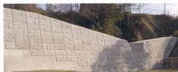
大阪府枚方土木事務所 発注 野崎中川床固工事
