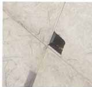
端部を切断し水抜き位置を決め、仕上げはモルタル処理
